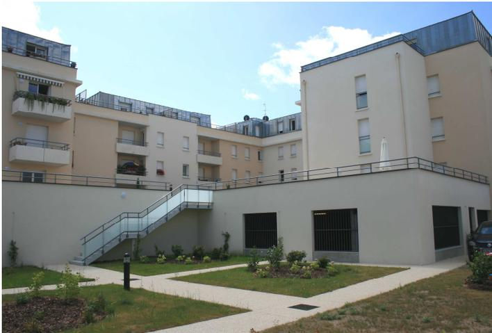
Situé en zone inondable, le rez de chaussée est un parking, aussi en façade, nous avons voulu matérialiser ce socle par un élément très opaque depuis la rue et très ouvert en cœur d'îlot permettant l'éclairage et la ventilation de ces locaux.
